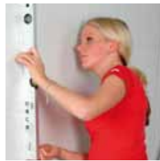
KROK 1 Ověřte zda úhel mezi stěnou a podlahou činí 90°.
