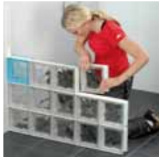
KROK 7 Pokračujte dle kroků 2-5 dokud nemáte hotových 5 nebo 6 řad luxfer. Počkejte 24 hodin, než začnete zdit další řady.
