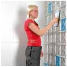
KROK 9 Počkejte 24 hodin, než začnete stěnu spárovat. Používejte kvalitní spárovací hmoty, které nepoškrábou sklo a nepraskají.
