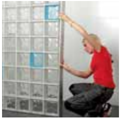
KROK 8 Prvních 24 hodin po dokončení nemusi být stěna zcela pevná. Lepidlo zcela vytvrdne až po cca. 3 týdnech.
